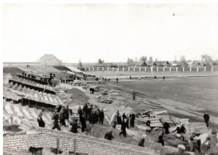
Рис.3. Строительство стадиона. Фотограф: Ефим Кузнецов, 1960 гг.
